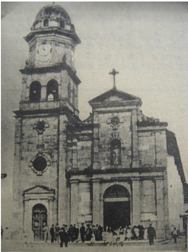
Iglesia de San Bernardino antes del terremoto de 1967
