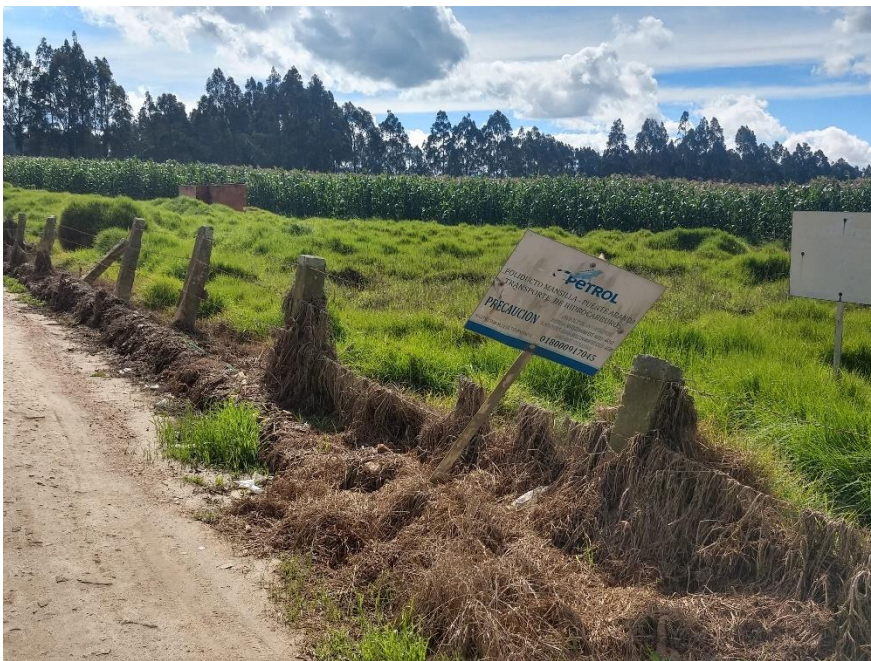
Figura 21. Aviso del paso de Poliducto Mancilla-Puente Aranda
