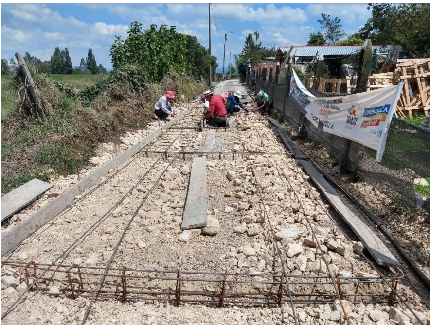
Figura 16. Habitantes de la Vereda Laguna Larga construyendo la placa huella de ingreso al poblado.
