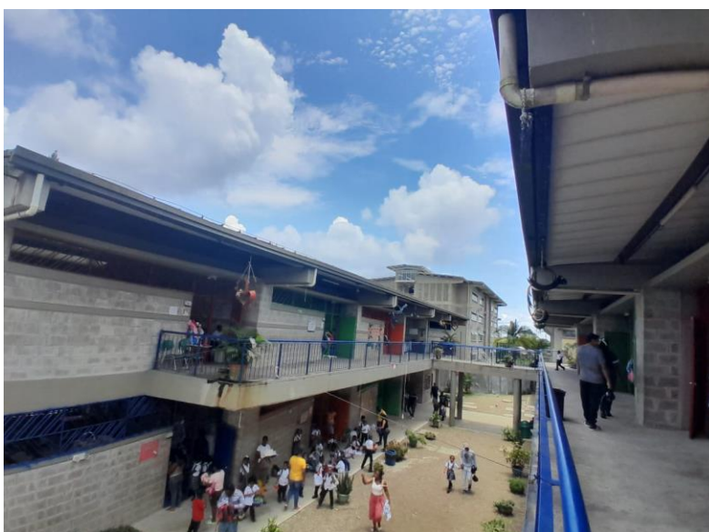
Imagen 11. Vista segundo piso edificio de grados cero a primero, Sede Anexa. Fuente propia.
