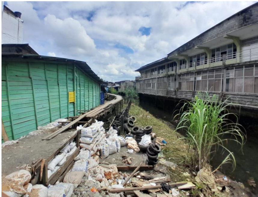
Imagen 4. Puente de madera, entrada al barrio La Yesquita. Fuente propia.
