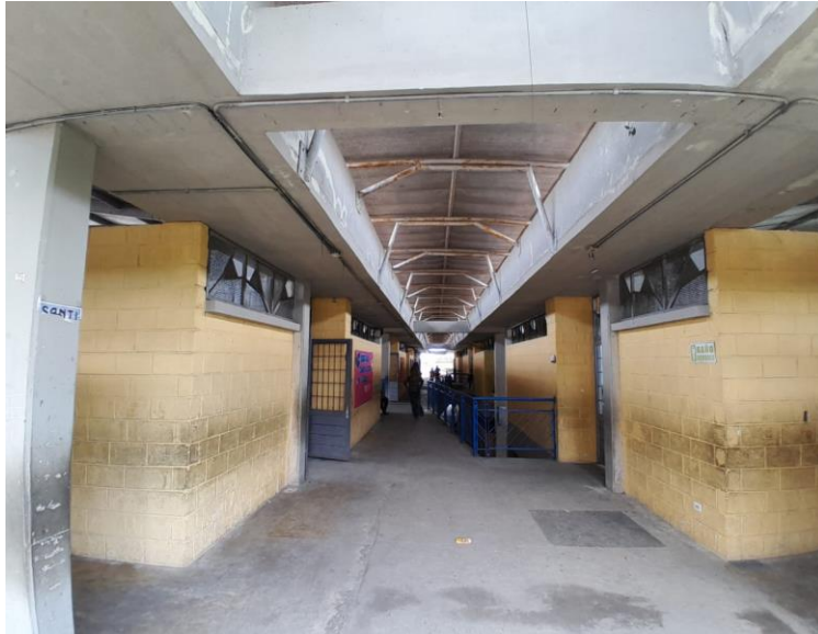
Imagen 16. Pasillo segundo piso del edificio de los grados segundo y tercero. Fuente propia.
