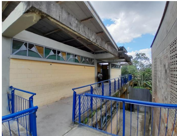
Imagen 14. Entrada por el segundo piso al edificio de los grados segundo y tercero. Fuente propia.
