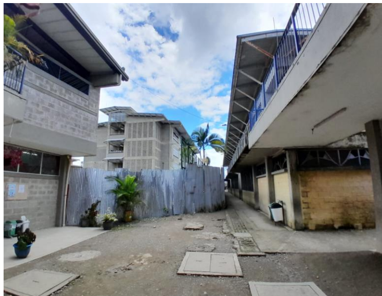
Imagen 15. Entrada por el primer piso al edificio de los grados segundo y tercero. Separación con láminas de aluminio con la sede de bachillerato. Sede Anexa. Fuente propia.
