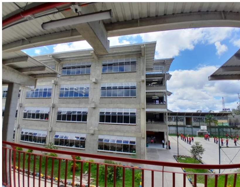
Imagen 10. Vista al Edificio 2. Grado sexto a noveno. Sede Anexa. Fuente propia.
