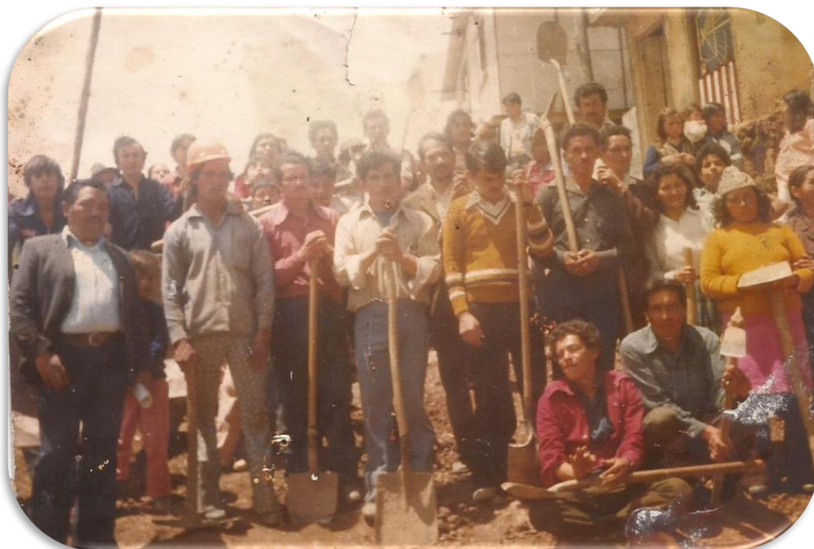
Ilustración 1. Construcción del muro de contención de la zona "Tierradentro". Fotografía recuperada de un álbum familiar.
