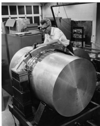
Ilustración 14 Uno de los primeros detectores de ondas gravitacionales, construido por el ingeniero James Weber en los años 60, colecciones especiales Universidad de Maryland, 2016, tomado de https://www.eurekalert.org/news-releases/896438
