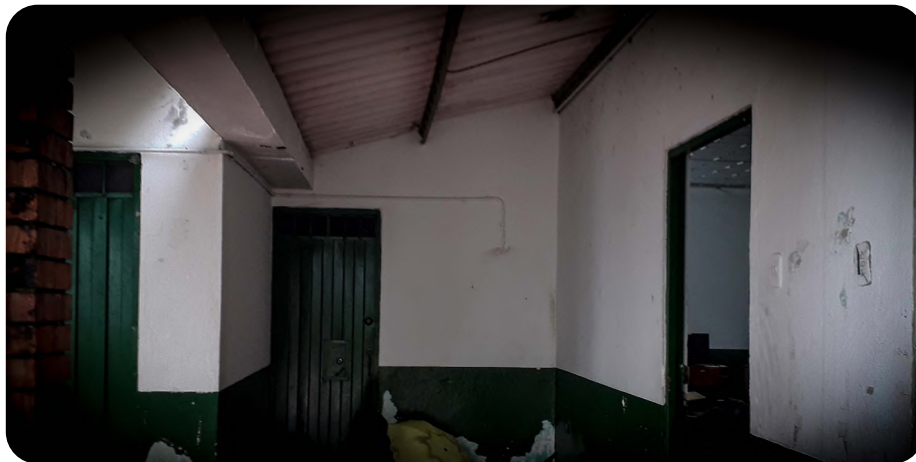
Vista desde el patio antes de la intervención.
