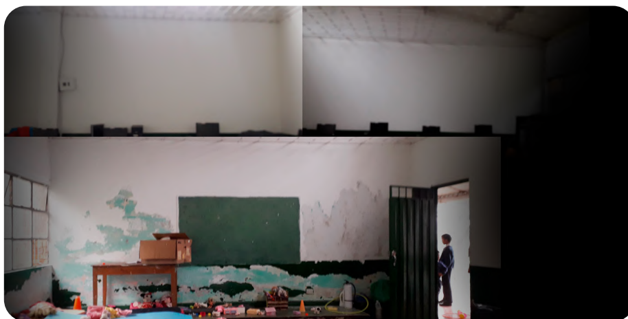
vista del salon de tecnología antes de la intervención.
