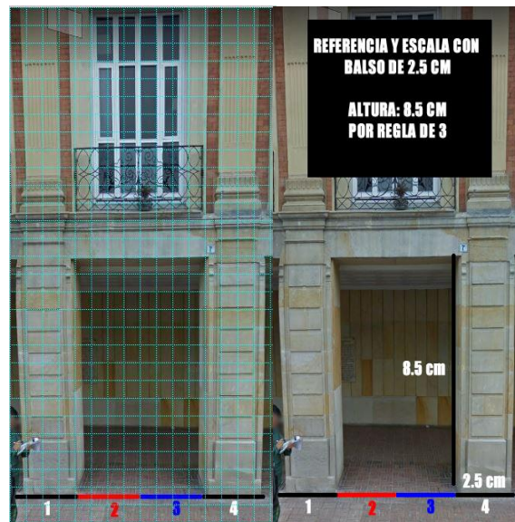
Figura 72 Creación del Patrón de Referencia, para la Construcción de las Columnas a Escala Fuente: propia
