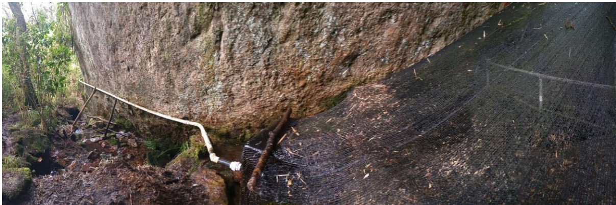
Fotografía 11 Bocatoma. Fuente propia. Archivo de las investigadoras. 2022.
