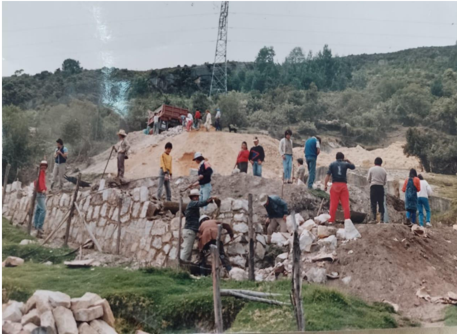
Fotografía 14 Construcción del Polideportivo en 1986. Fuente Archivo JAC. 2022.
