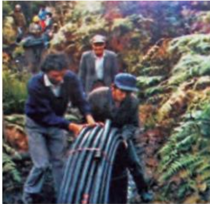
Fotografía 12 Construcción del acueducto comunitario. Fuente Secretaria Distrital de Planeación. 2015.
