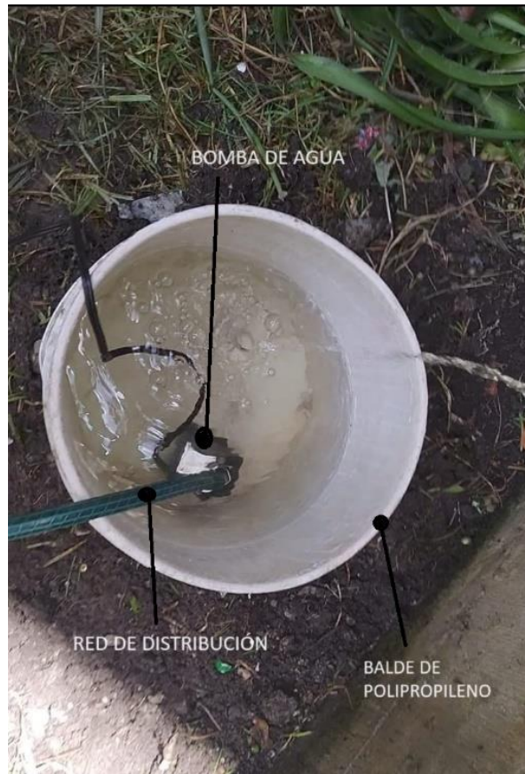
Ilustración 3. Bomba de agua, red de distribución, Balde de polipropileno. Fuente: Elaboración propia
