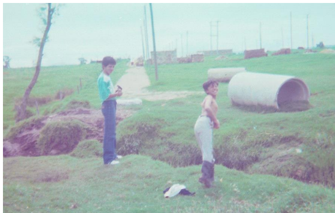
Foto 3.42. Construcción del alcantarillado barrio Aures 1, inicios de la década 1980
