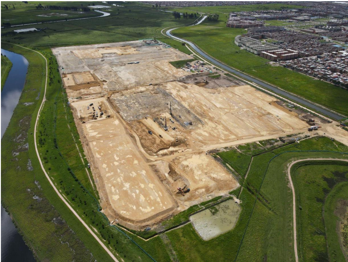
Fotografía 7 Lugar de implementación del patio taller y la proximidad de la ciudad a la frontera de la ciudad. Fotografía de Metro de Bogotá, disponible en: Nuestro metro en obras | Metro de Bogotá | Estamos construyendo la Primera Línea del Metro (metrodebogota.gov.co)
