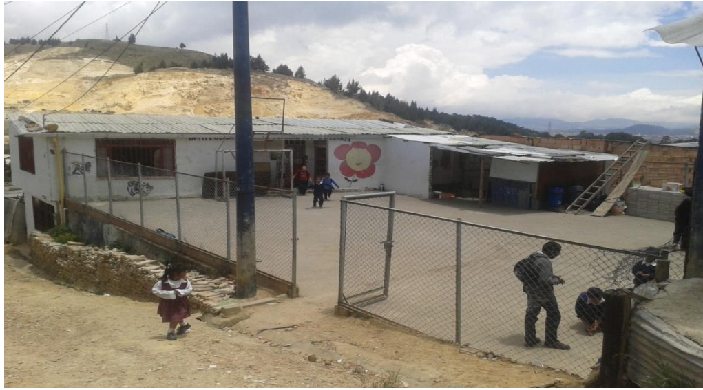
Fotografía 1. Condición estructural de la escuela
