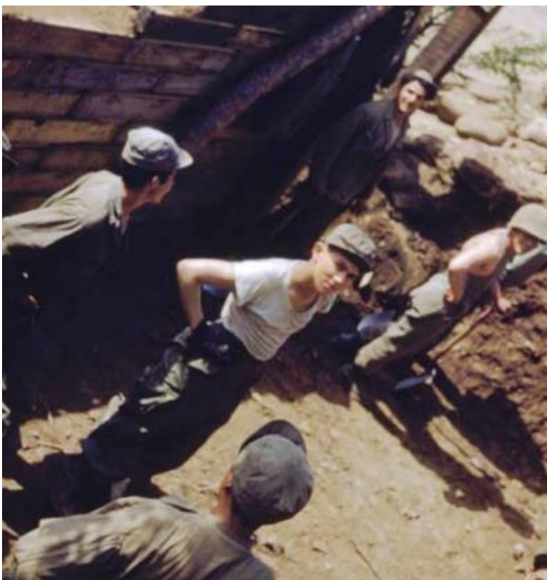
Foto 14. Soldados del batallón Colombia construyen una casamata. 1952. Extraído de: Colección fotografía sargento mayor Gilberto Díaz Velasco.
