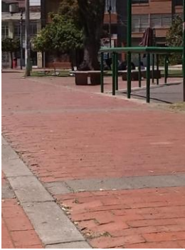
Fotografía 8. Registro de estado de pasillo interno del parque. Sierra, V. 2016
