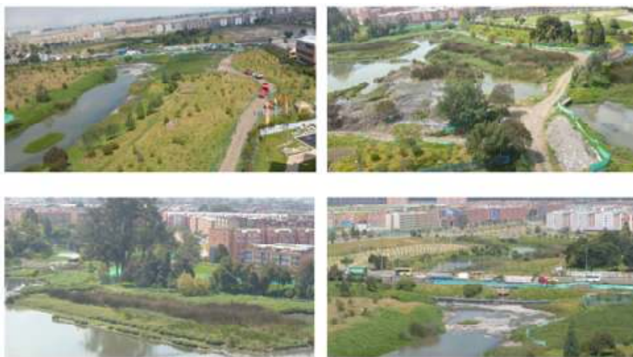
Figura 5. Obras realizadas por aguas de Bogotá en el humedal el Burro desde 2014 hasta la fecha.
