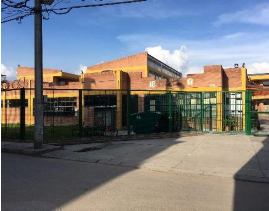
Imagen 3, Institución educativa distrital El Porvenir sede B (2022) Fuente propia.
