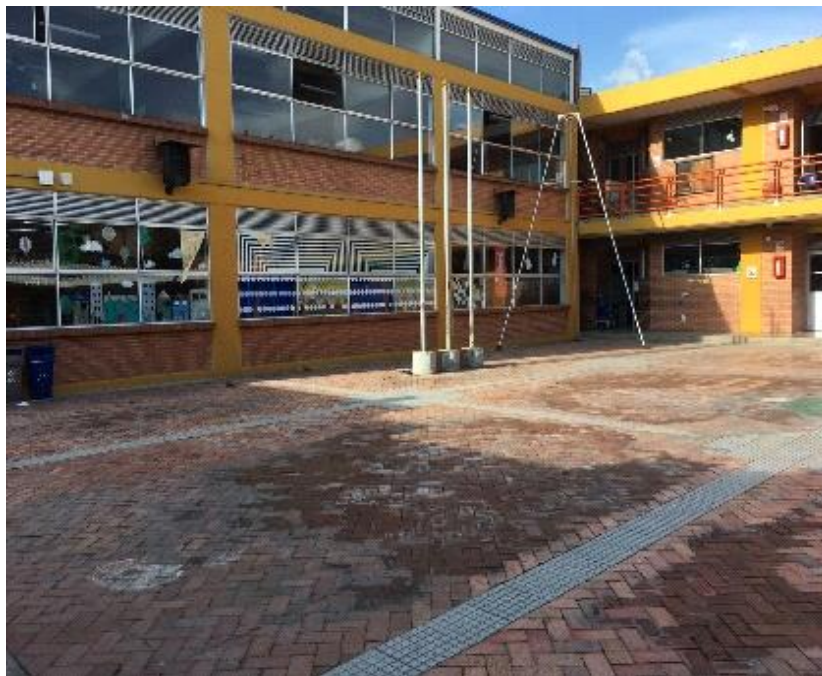
Imagen 2, Institución educativa distrital El Porvenir sede B (2022) Fuente propia.
