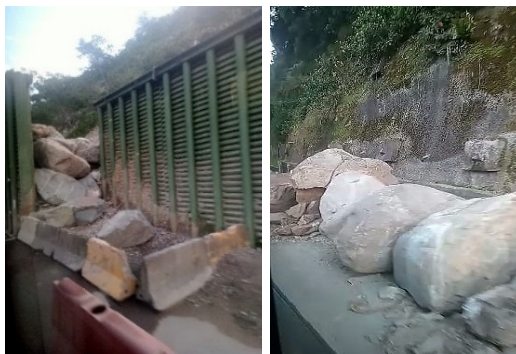
Figura 20 Derrumbe en la vía al llano, municipio de Guayabetal. Figura 21 Derrumbe en el municipio de Guayabetal. Registros propios (2023)
