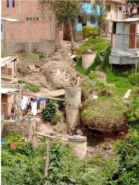
Foto 7: Erosión del suelo por efecto de la mal implementación del alcantarillado. Fotografía tomada por Lina Veromy, 2024.
