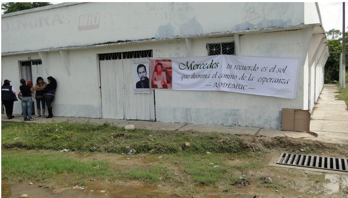
FOTO 10: Casa sindical de SINTRAGRIM ubicada en Medellín del Ariari, Meta. FUENTE: propia.
