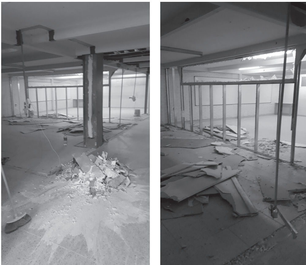
Figura 5.5. Imágenes espectrales. Primer piso del Edificio C, UPN, marzo del 2018
