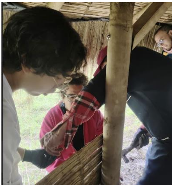
Figura 15. colocando la guadua para el mural del chunsua, foto tomada por Julián Hernández, 2025.
