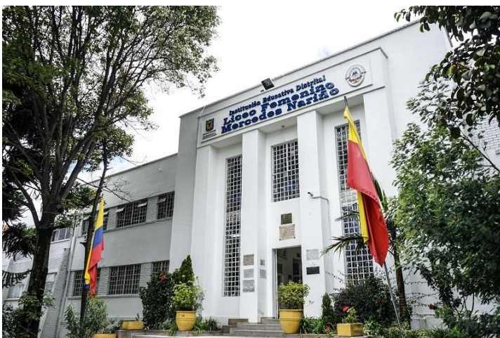
Fachada del edificio principal del colegio.
