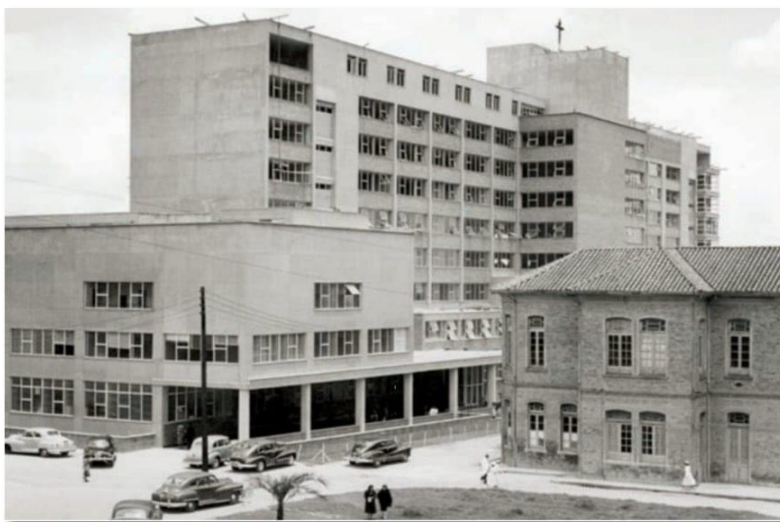
Ilustración 21. Construcción del “bloque compacto” la torre estilo americano.
