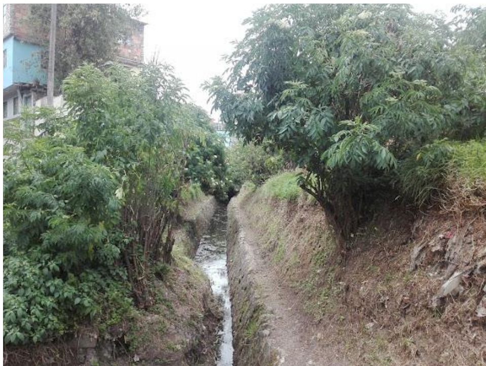
Fotografía 8 (Díaz J.2021) Canalización del arroyo Chorrerón
