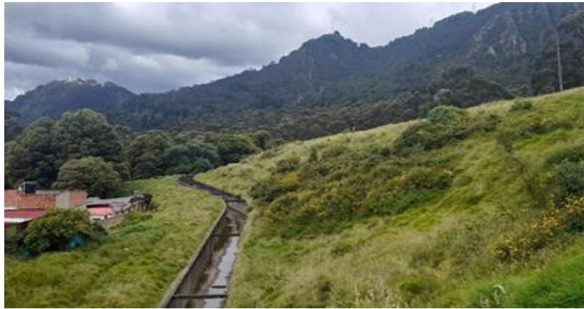
Fotografía 7 (Díaz J.2021) Canal limitante del sur cerca a los tanques de San Dionisio
