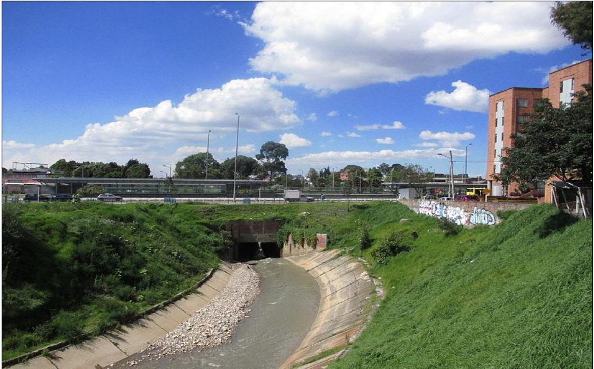
Figura 6. Canalización río Fucha carrera 10. Tomado de: https://es.wikipedia.org/wiki/R%C3%ADo_Fucha_
