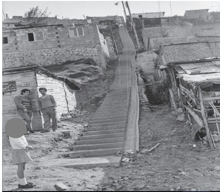
Ilustración 7 Fuente: Issuu- El palo del ahorcado. De la raíz a la resistencia (15 de Diciembre de 2022)
