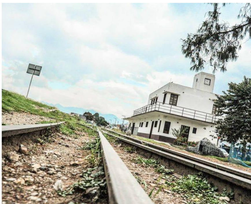
Fotografía 12: Estación de Tren , la imagen corresponde a una foto en perspectiva, en ella se observa la estación de dos pisos, sus ventanales y una torre de reloj, a su costado en el sentido norte se observan los rieles aun en uso. La ferretería ubicada en la estación férrea no sólo es dueña de una parte de la estación, también tiene un encerramiento con alambre y palos que le sirve de depósito para arena, grava, ladrillos, entre otros materiales. (Espinosa Y. F., 2024).
