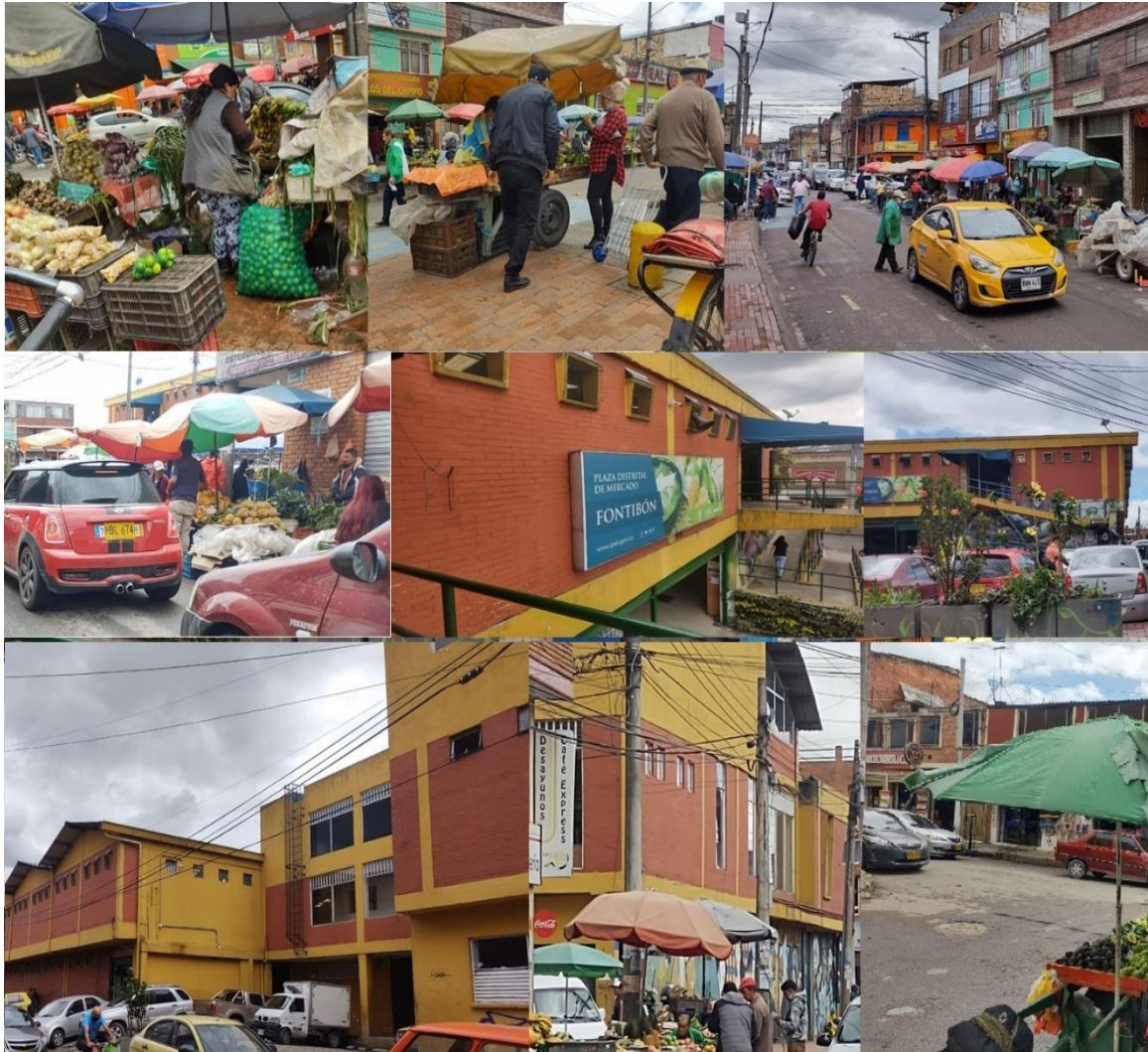
Fotografía 11: Mosaico Fachada , es la plaza en sus alrededores, se observa su fachada , la cual sobresale por su altura, dimensión y colores amarillos en las vigas con paredes de ladrillo marrón. Sobresale en comparación a las casas o negocios con los que limita, en sus cuatro esquinas sombrillas, transeúntes y un número amplio de automóviles; en la parte inferior de la imagen se observa la zona de carga así como la parte de atrás de la segunda planta. (Espinosa Y. F., 2024).
