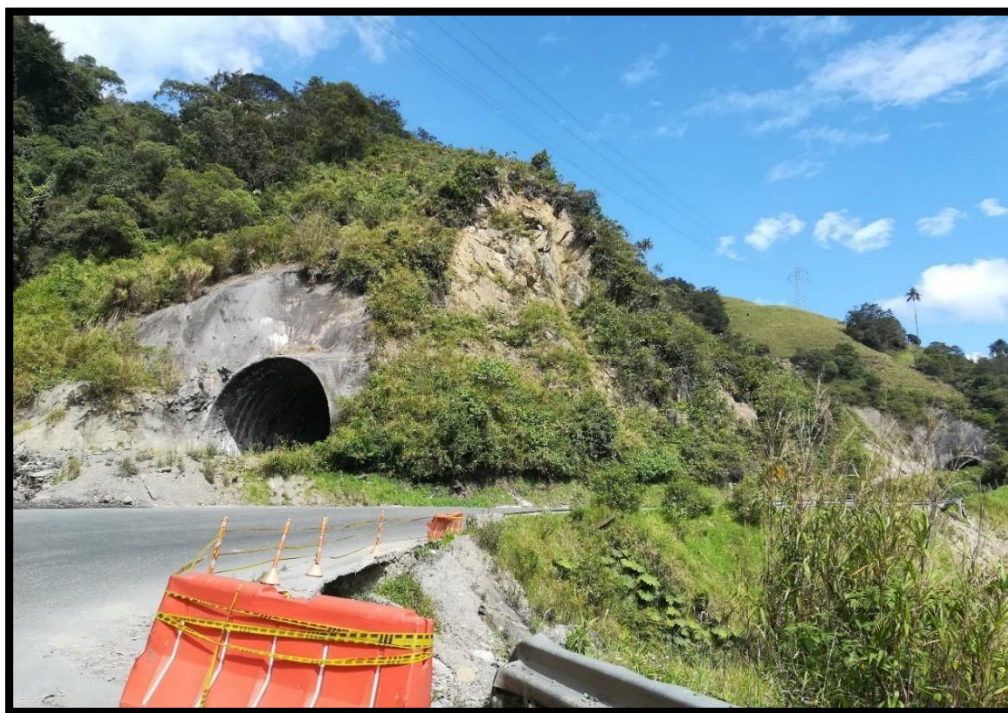
imagen 16: sistema de túneles abandonados fuente elaboración propia
