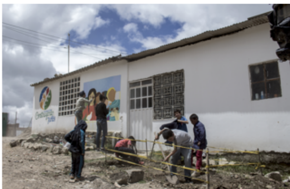
Fotografía 16. Por Ana Arellano (2017) Niños y voluntarios pintando la casa y construyendo el jardín.
