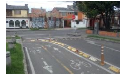
Vandalismo Foto 79a
