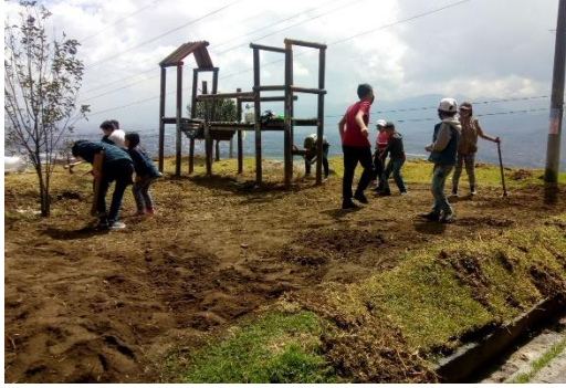
Ilustración 14. Construcción de la Escuela Agroecológica. Tomada de: Acevedo, 2020.
