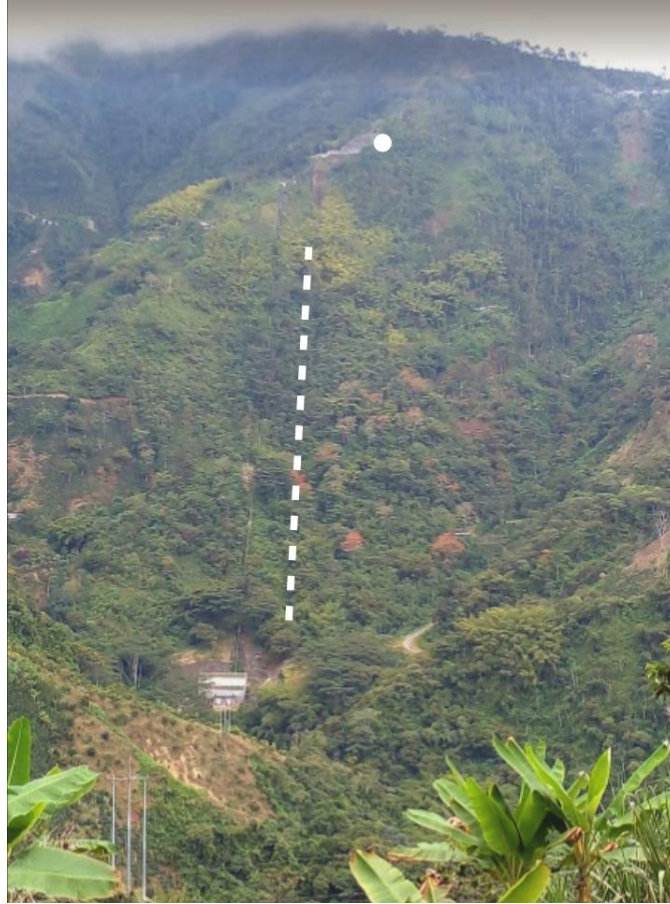
Figura 7. Unidad Pequeña Central Hidroeléctrica El Edén
