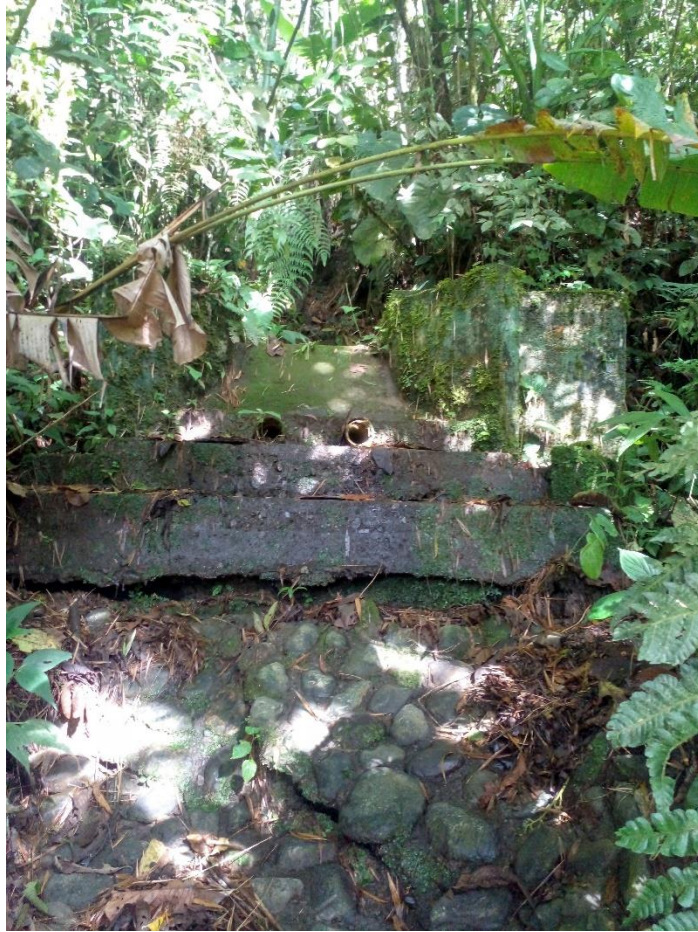
Figura 9. Antiguo paso de la Quebrada La Balastrea (Seco)
