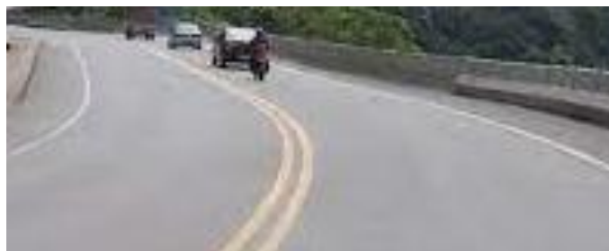
Ilustración 20. Vía en buen estado.
