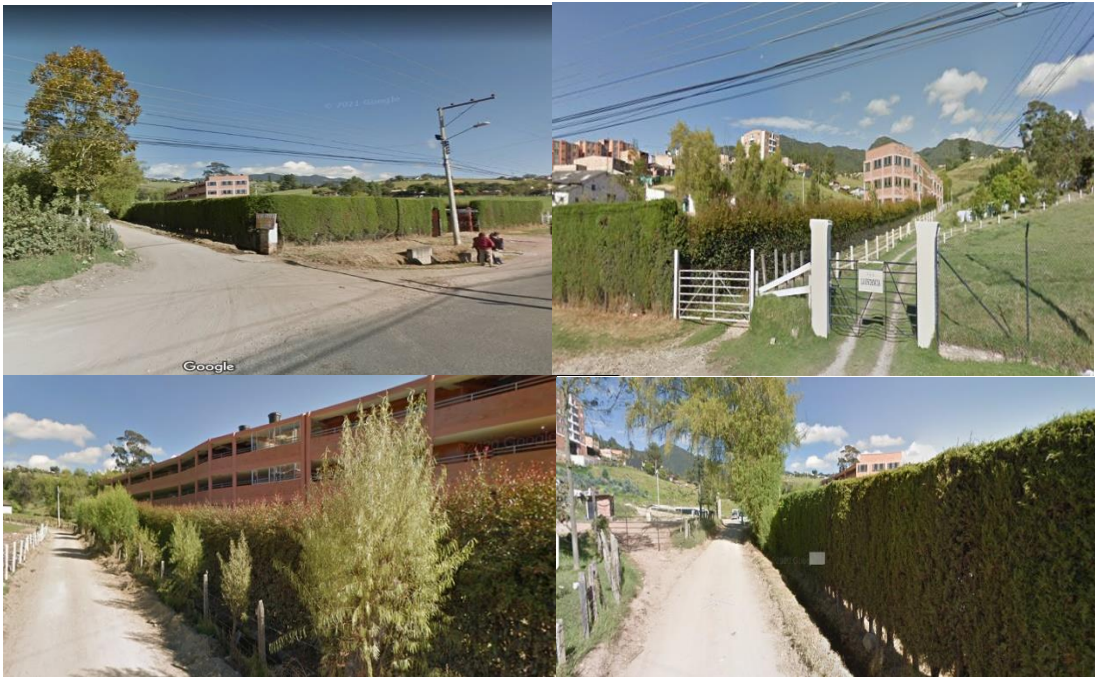
Imagen N°1. Localización de la institución, colegio gimnasio San Mateo. (Tomado de Google maps)
