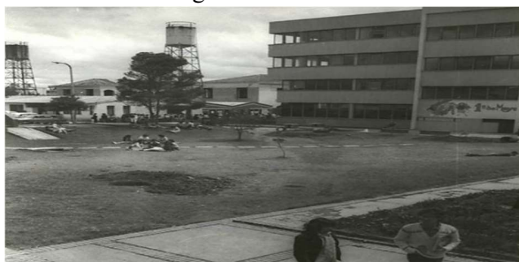
Imagen N° 7. Plaza de la solidaridad en la década de los años 70. Al fondo se observa la antigua construcción conocida como casita de audiovisuales y a la derecha el edificio B, inaugurado en 1969. Tomado de: http://museopedagogico.pedagogica.edu.co/upn-en-imágenes/
