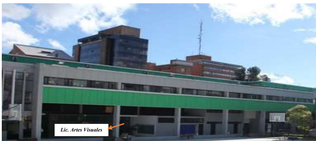
Imagen N° 18 Costado del edificio C por donde se ubican las chasas Tomado de: http://imagenes.pedagogica.edu.co/picture.php?/2577/search/2592
