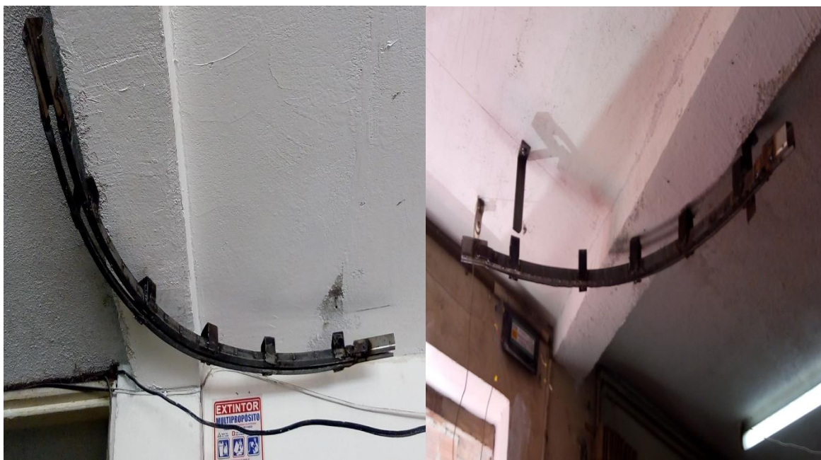
Figura 19: Anclaje de los rieles al techo por medio de chazos. Fuente propia
