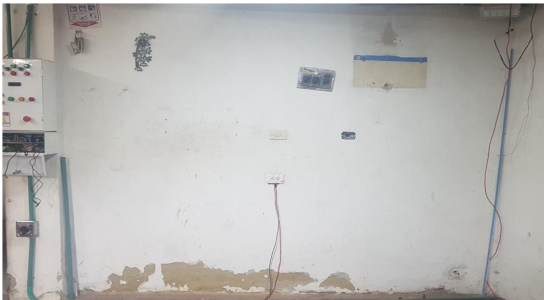
Figura 47: Espacio para hacer la cortina de agua. Fuente propia
