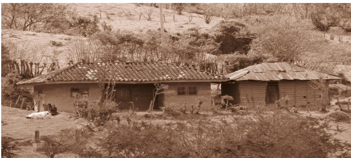
Foto 2. Primer escuela construida, que aún mantiene parte de su estructura. Ahora es la casa comunitaria de la recuperación la Palma. Archivo personal, Octubre de 2009.
