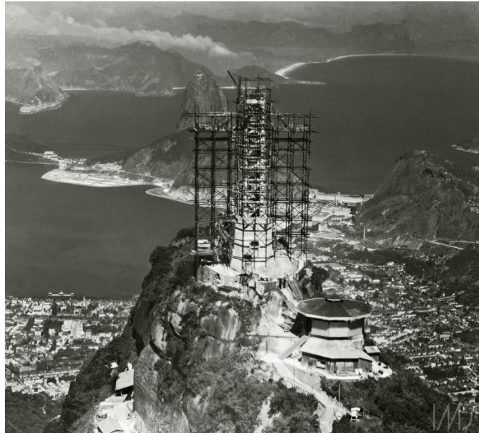
Figura No 29: Construcción del Cristo Redentor en el Parque Nacional Tijuca. Fuente: shorturl.at/qBLRT (21/12/19)
