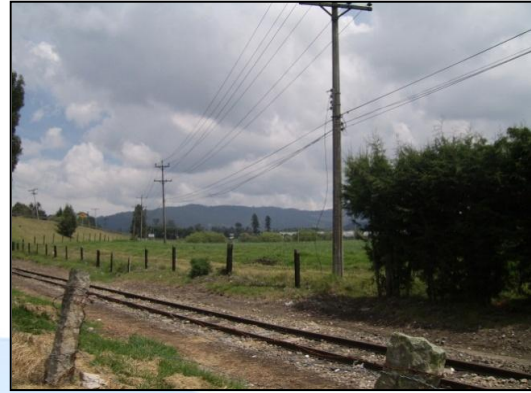
La carrilera del tren que está en la parte de atrás de la escuela
