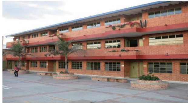
Fig. 3. Vista Interna del Colegio
