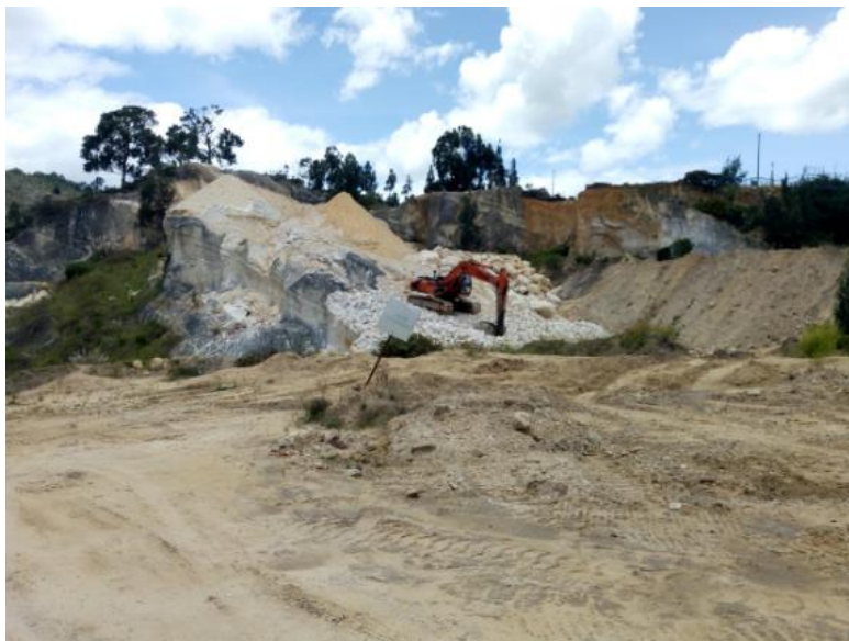
Fotografía 27. Ampliación de carretera para parqueo de volquetas, muy cerca de viviendas campesinas. Fuente: propia, 03 de mayo 2022.
