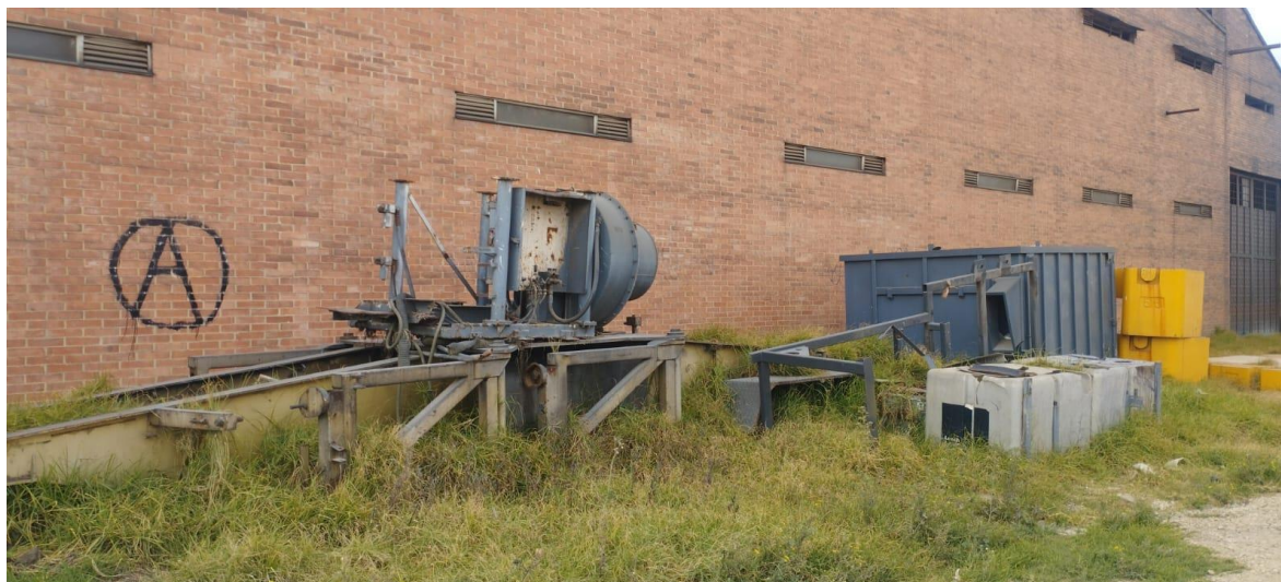
Figura 17 Estructura de metal abandonada
