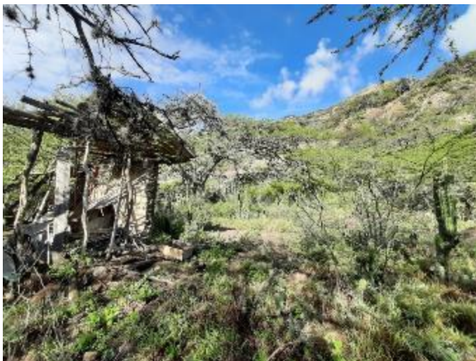
Fotografía 37 El paso del tiempo Álbum personal (2021) En la foto se puede observar una casa en abandono que se resiste a caer. Alrededor, la naturaleza reclama su espacio. El Melonal, Boavita, Boyacá
