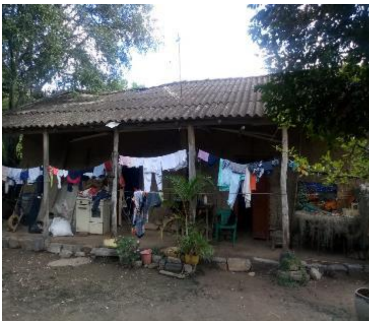
Fotografía 8 Construcción en tapia
