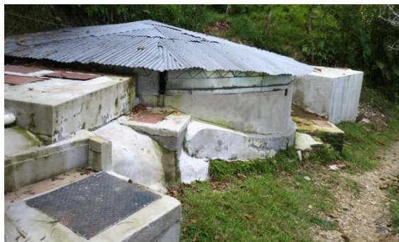
Imagen 1. Tanque con caja de inspección. Tomada por Pinzón, R. (2020).
