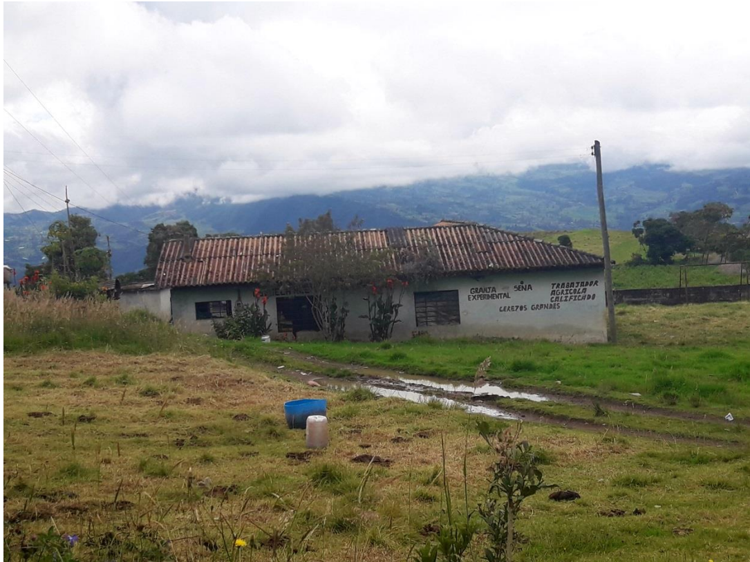
[Fotografía de los autores] Antigua Escuela de Cerezos Grandes. 2017.
