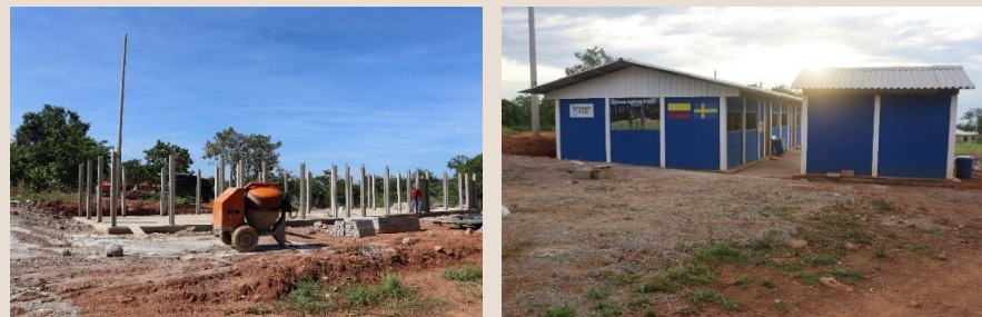
Figura 39. Construcción colectiva de la escuela de Tierra Grata dirigida por obreros suecos. Archivo personal de los autores, 2023.
