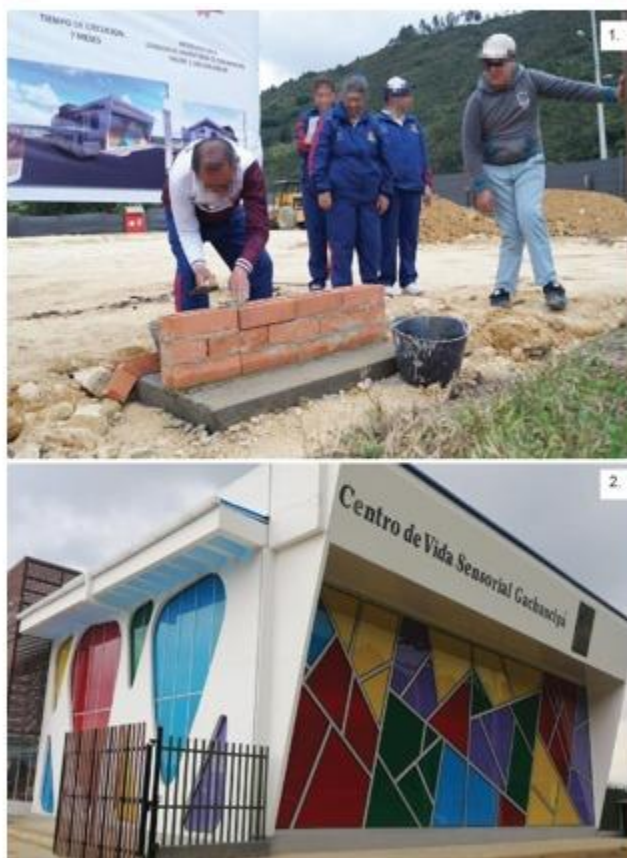
Figura 2. Inicio de su construcción y mega obra final
