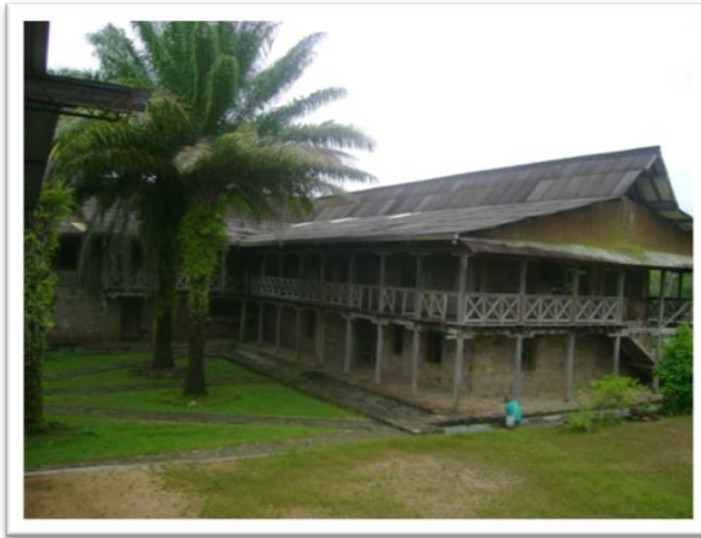
Foto 1. Antiguas instalaciones Casa Arana actual casa del conocimiento (Registro, Marco Tulio Peña, marzo de 2008)
