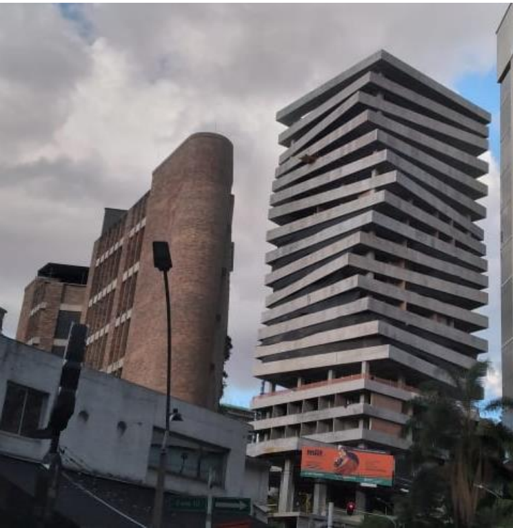
FIGURA 20. PROYECTO INMOBILIARIO EN CONSTRUCCIÓN, SECTOR PROVENZA
