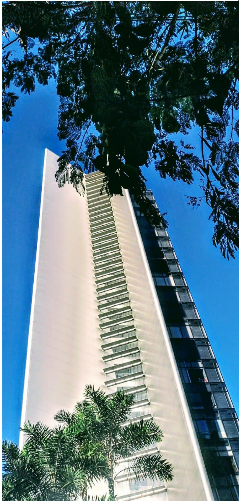
FIGURA 53. FOTOGRAFÍA DE COSTADO DEL EDIFICIO EN MENCIÓN
