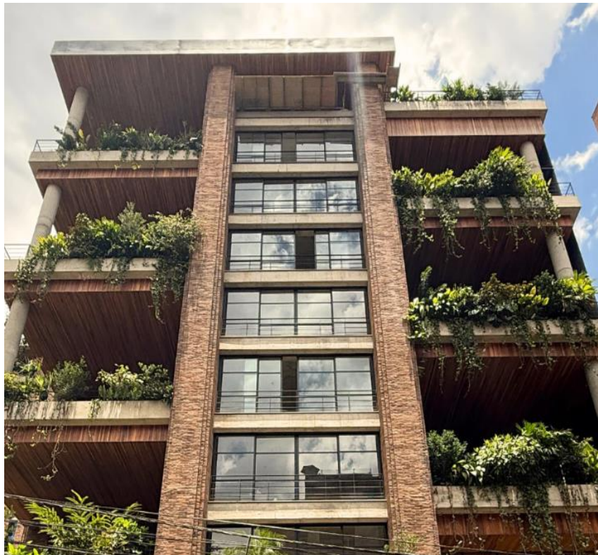
FIGURA 21. PROYECTO INMOBILIARIO EN CONSTRUCCIÓN, SECTOR LAS LOMAS I
