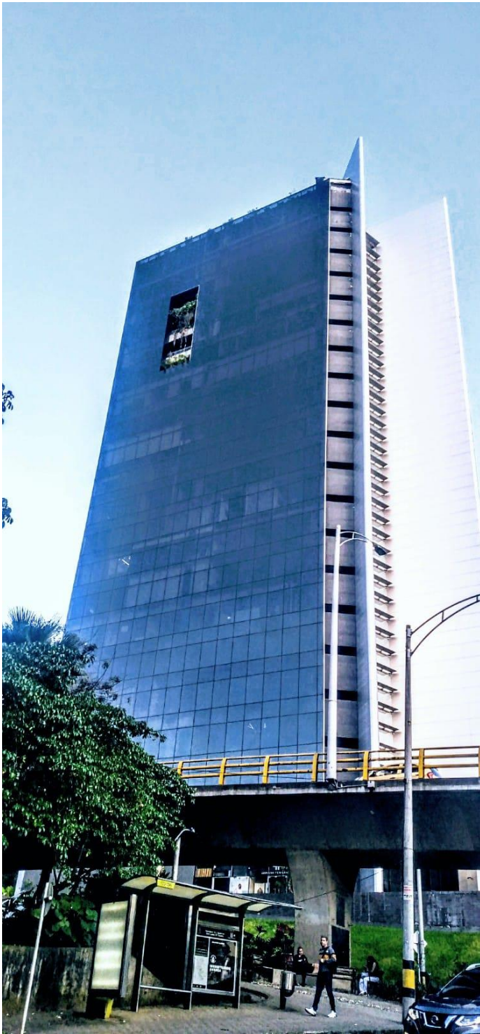
FIGURA 52. FOTOGRAFÍA FRONTAL DEL EDIFICIO EN MENCIÓN DURANTE LA ENTREVISTA
