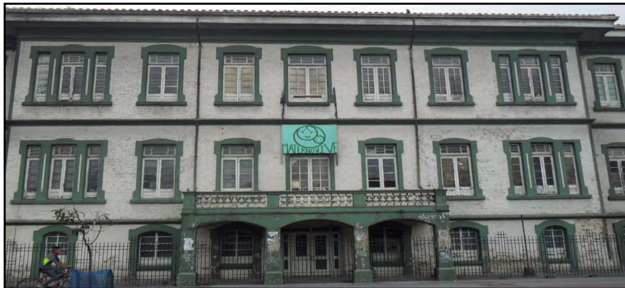
Imagen 19. Deterioro del hospital Materno infantil
