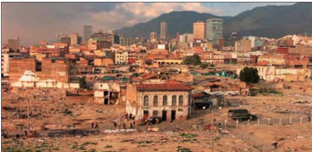
Imagen 13 . Demolición del cartucho
